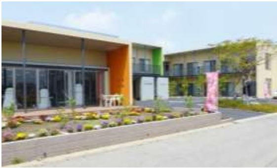
ケアプラザ矢板全景
